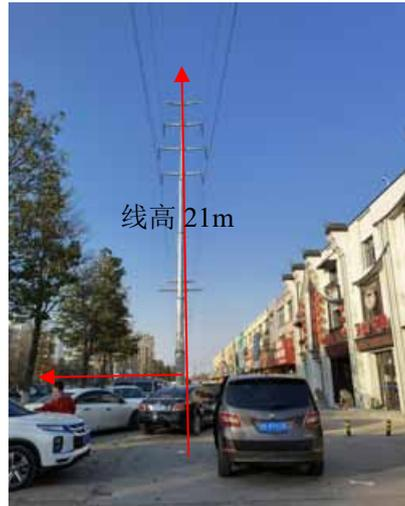
图 7-2 官云线/匡泰线双回架空衰减处
