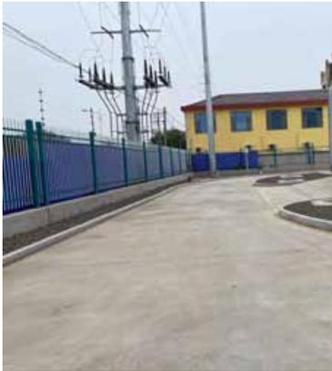
图6-3 变电站内路面硬化
